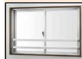
転落防止の手すりの設置
